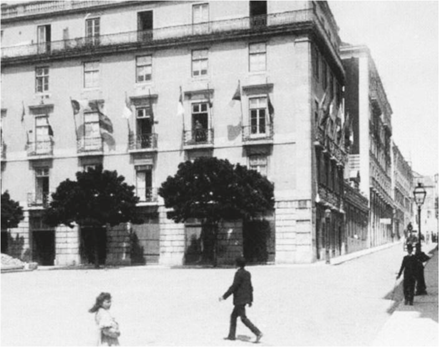
Casa onde nasceu Pessoa
